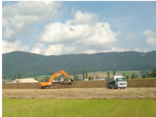
Zone de stockage des matériaux à Courrendlin
