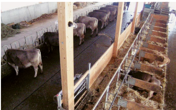
Si on installe des logettes adossées à la paroi, les aires d'affouragement, de repos et de sortie se trouvent l'une à côté de l'autre tout en étant séparées.
