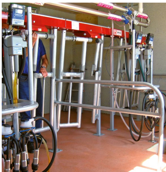
Pour convenir aux vaches à cornes, la construction de la salle de traite Butterfly doit éventuellement être ajustée.
